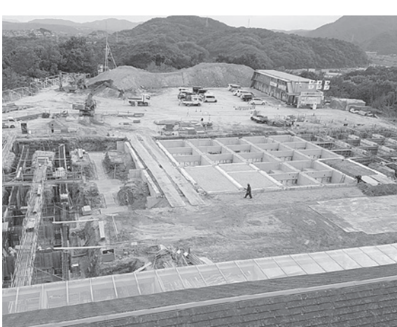
▲順調に工事が進む新校舎建設風景(撮影:6月28日)
